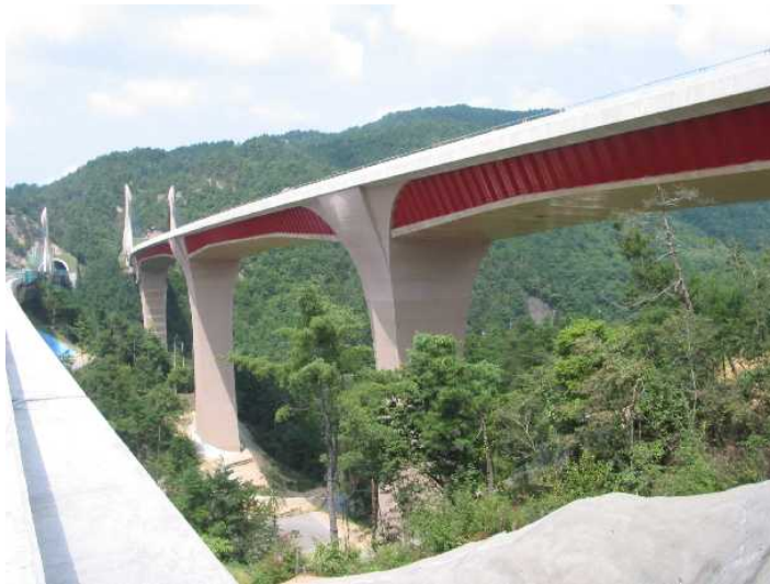
2006年8月施工完了直後撮影
