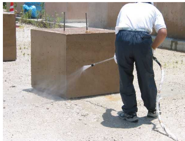
高圧水洗浄をした面
