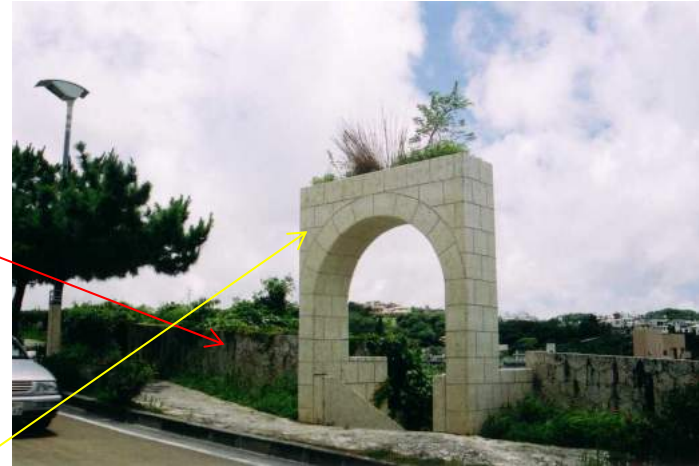
平成18年(2006年)施工13年後
